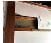
④ 撤去完了
