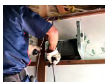
② 撤去作業
