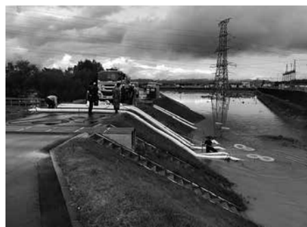
内水の排水作業の様子
