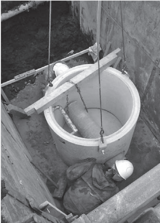
下水道工事の様子
