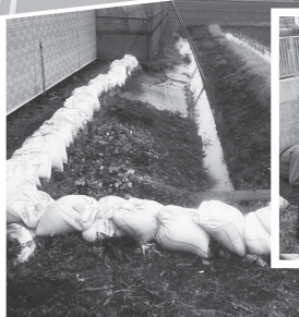
土のう積み作業
