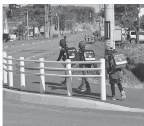
道道旭川幌加内線 ガードレール設置
