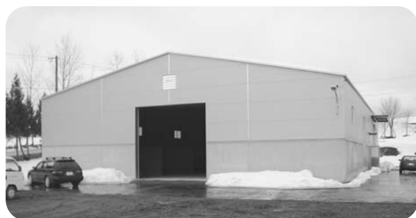
生ごみ堆肥化施設
