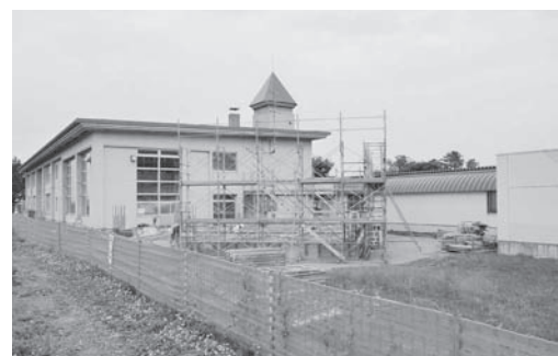
増築工事中の北野小学校
