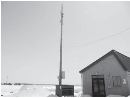
インターネット無線アンテナ(11区区会館前)
