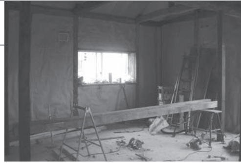
改修中の空き家
