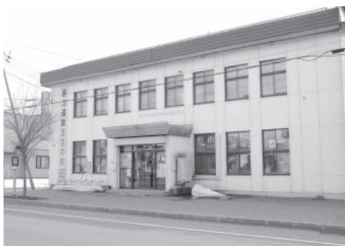
解体前のたいせつ農協鷹栖支所
